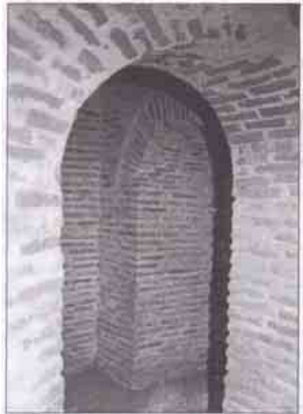
Arqueta, arcos y bóveda del encaño.
