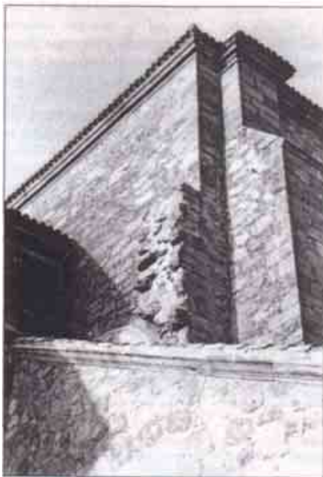
5. Arranque de muro en la iglesia de Santiago.
