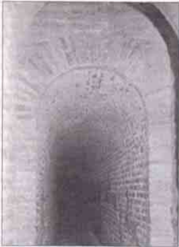
Arcos de ladrillo de la galería principal o mina del encaño
