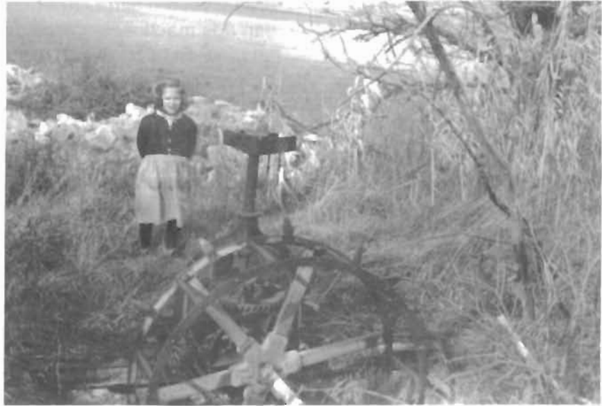
Restos de una noria moderna con cigüeñal de hierro. Camino Corral, junto Huerta Chocón
