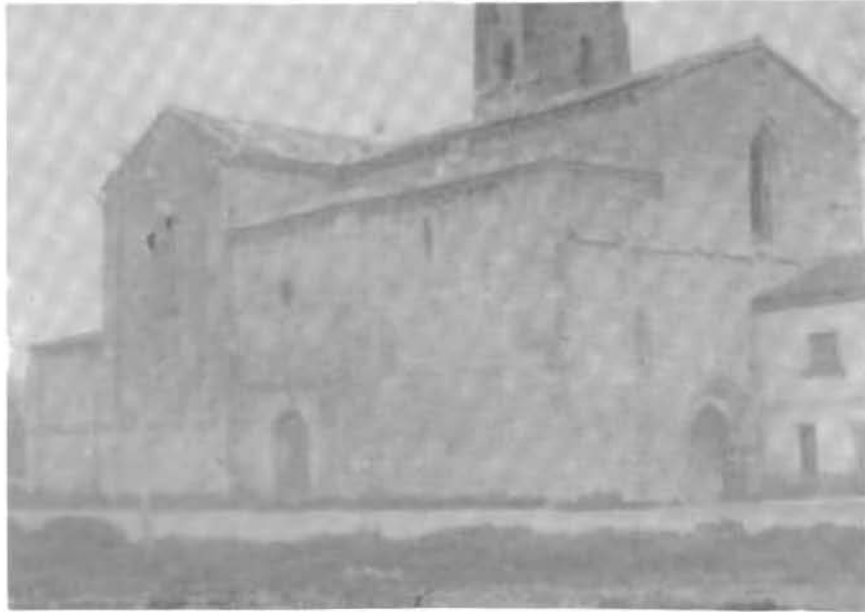
Fachada principal del Monasterio de Santa Cruz de la Zarza
