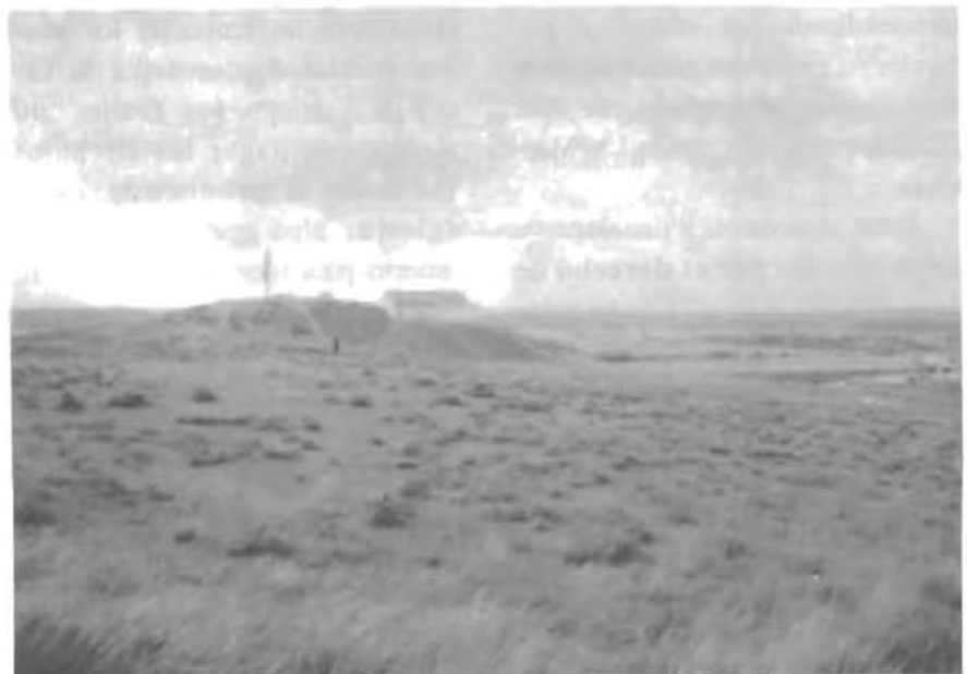
Las ruinas del Castillo de Alarilla y la ermita.
