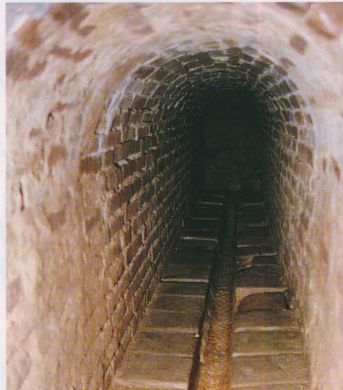
Acueducto subterráneo que abastece la fuente de los caños, su construcción data de hace muchos siglos.
