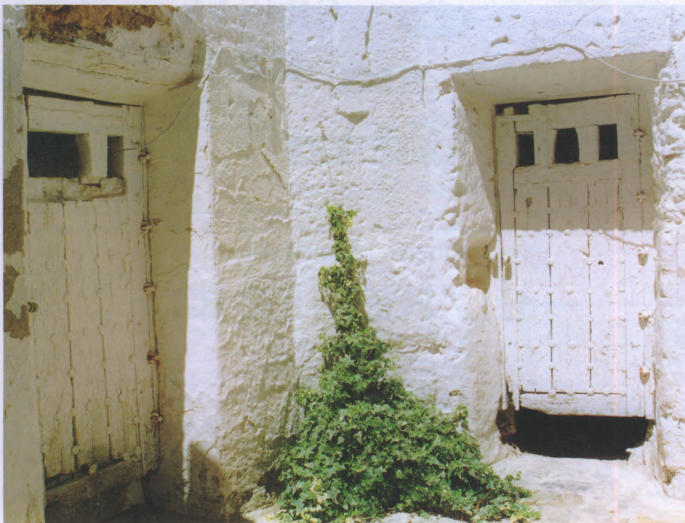
Calabozos del Ayuntamiento. Planta Baja. Plaza de la Constitución.
