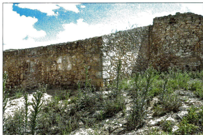
Exterior de la Ventana Saetera tapiada
